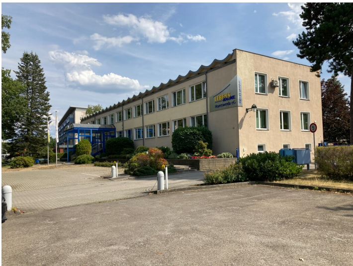
Verwaltungsbau im Wohnkomplex III Fotograf/Urheber: Matin Neubacher
