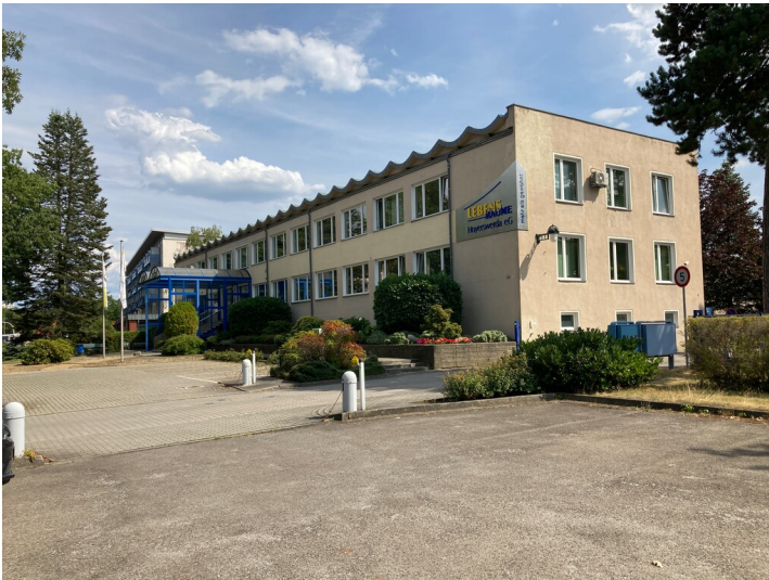
Verwaltungsbau im Wohnkomplex III Fotograf/Urheber: Matin Neubacher
