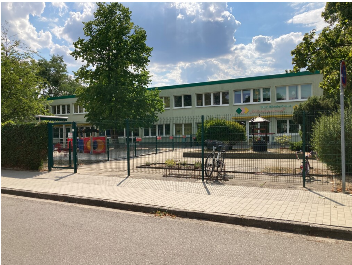
Kindergarten im Wohnkomplex III Fotograf/Urheber: Matin Neubacher
