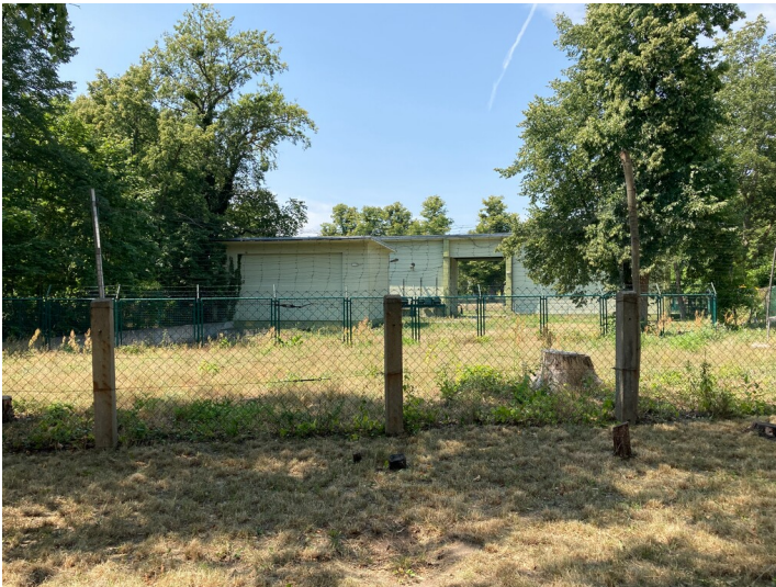
Pumpenhaus im Wohnkomplex II Fotograf/Urheber: Matin Neubacher
