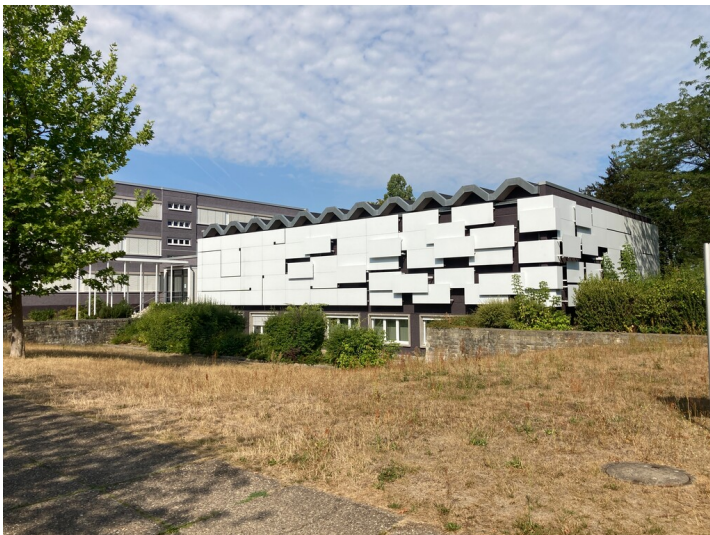
Bürogebäude im Wohnkomplex I Fotograf/Urheber: Matin Neubacher
