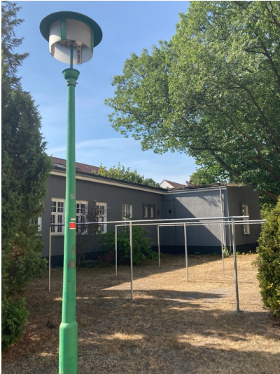
ehem. Wohngebietsgaststätte »Grubenlampe« im Wohnkomplex I Fotograf/Urheber: Matin Neubacher
