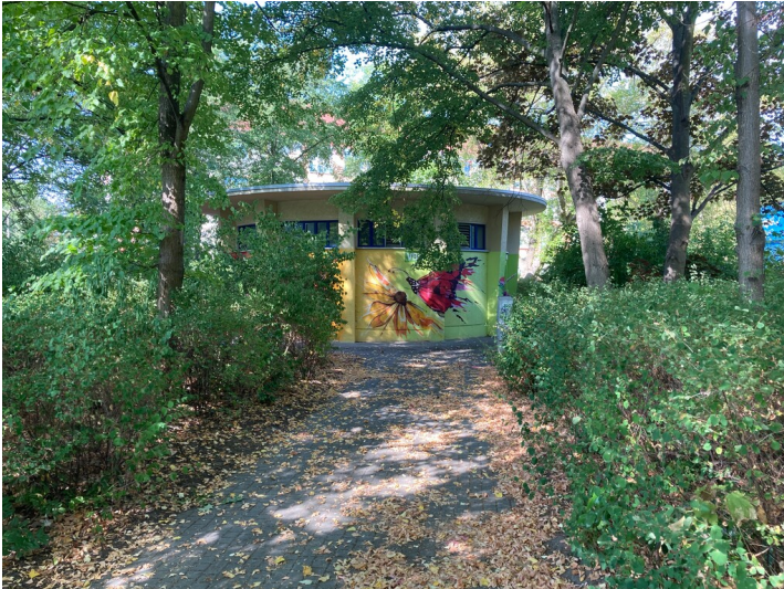
Abwasserpumpstation Wohnkomplex I Fotograf/Urheber: Martin Neubacher
