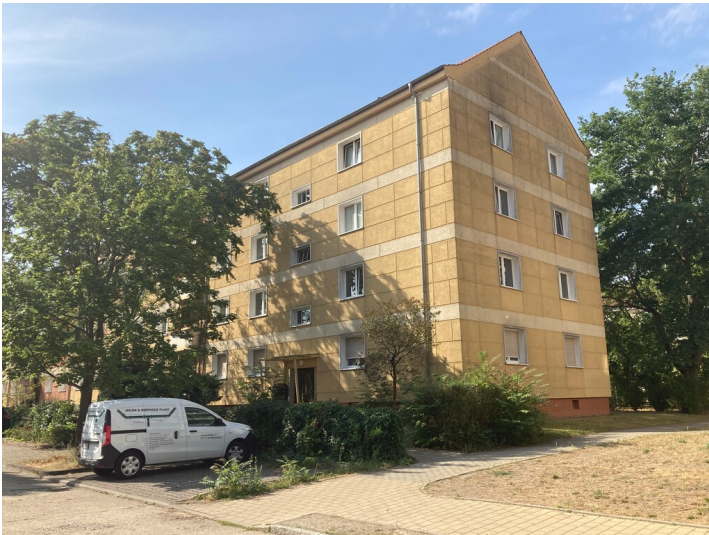
Wohnblock Otto-Damerau-Straße 2; 4; 6; 8; 10 Fotograf/Urheber: Matin Neubacher
