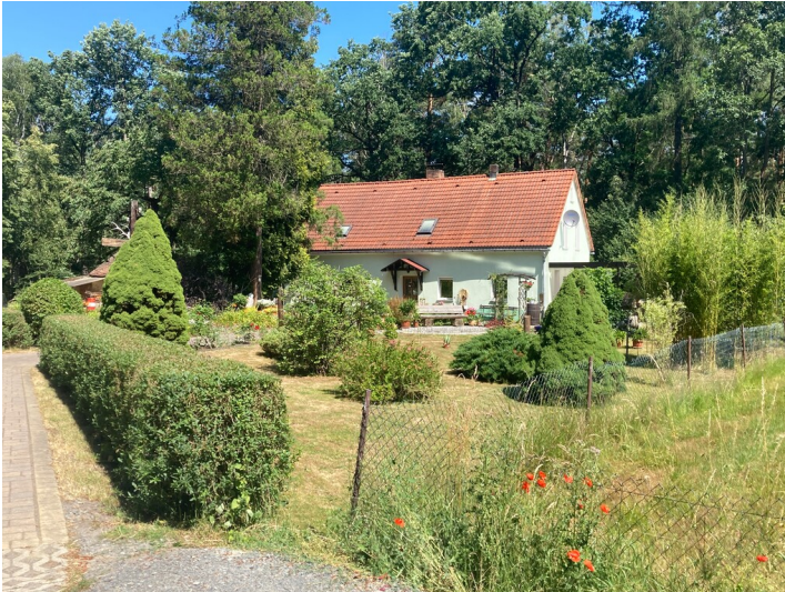
ehem. Außenstelle der Eintrachtwerke Zeißholz Fotograf/Urheber: Martin Neubacher
