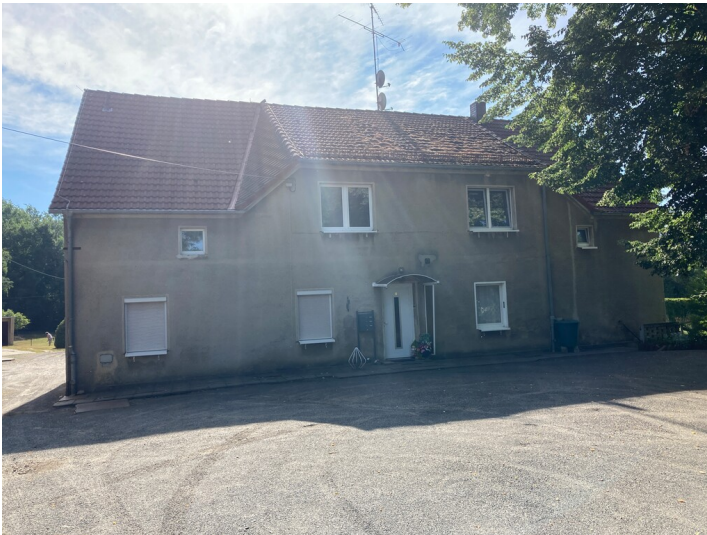
Kontorgebäude der ehem. Glashütte Scheckthal Fotograf/Urheber: Matin Neubacher
