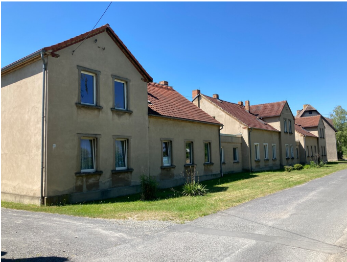
Wohnhäuser der Siedlung Aktienhütte Fotograf/Urheber: Matin Neubacher
