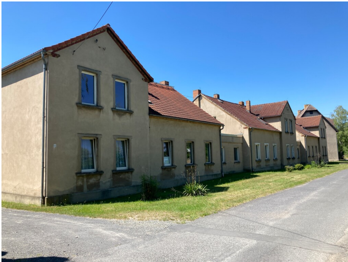
Wohnhäuser der Siedlung Aktienhütte Fotograf/Urheber: Matin Neubacher
