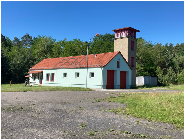
Werkfeuerwehr der ehem. Brikettfabrik Zeiholz Fotograf/Urheber: Matin Neubacher
