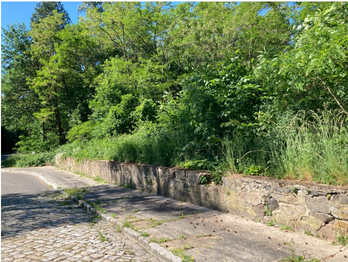
Einfriedung der ehem. Brikettfabrik Zeiholz Fotograf/Urheber: Kathrin Kruner
