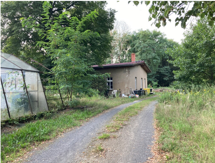
Einfamilienwohnhaus der ehem. Werksiedlung Saxonía Fotograf/Urheber: Kathrin Krüner
