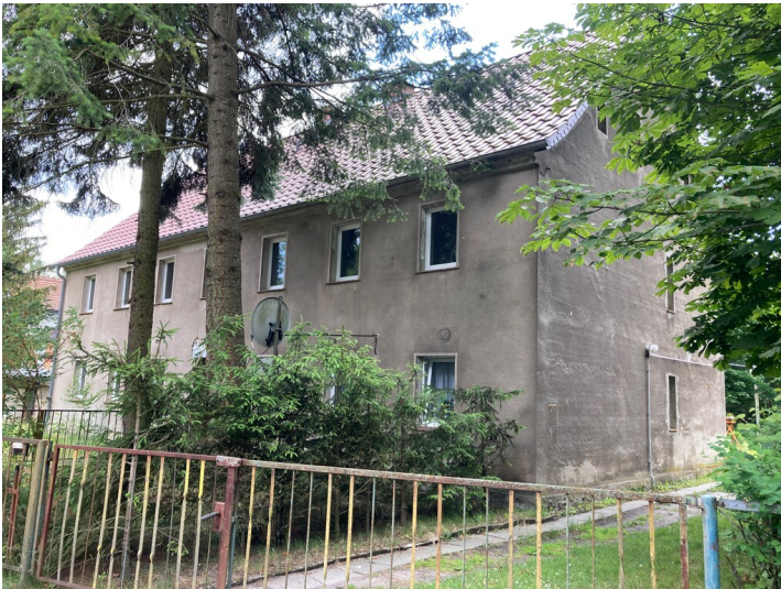
Mehrfamilienwohnhaus der ehem. Werksiedlung Saxonía Fotograf/Urheber: Kathrin Krüner
