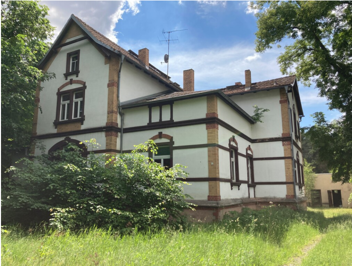
ehem. Direktionsgebäude der Tiefbaugrube Saxonía Fotograf/Urheber: Kathrin Krüner
