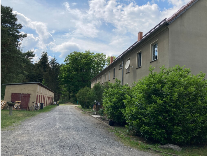
Mehrfamilienhaus in der ehem. Werksiedlung Saxonía Fotograf/Urheber: Kathrin Krüner
