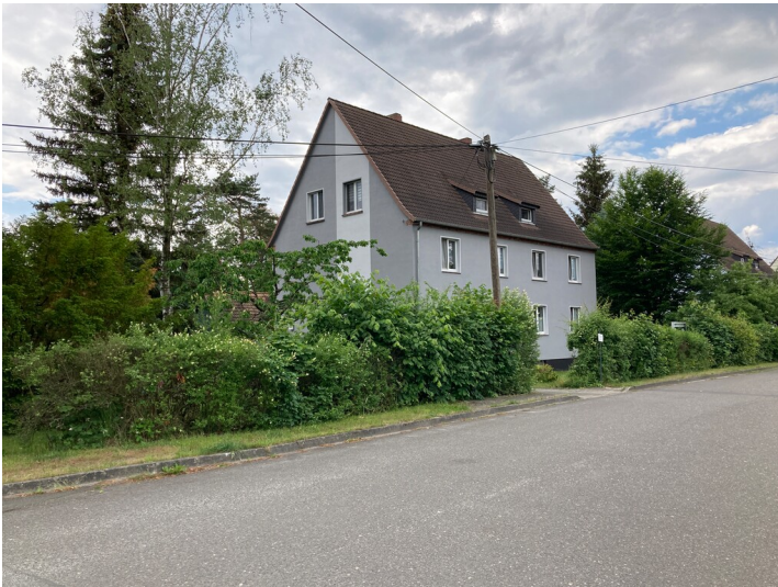
Mehrfamilienwohnhäuser der ehem. Werksiedlung Heye III Fotograf/Urheber: Martin Neubacher
