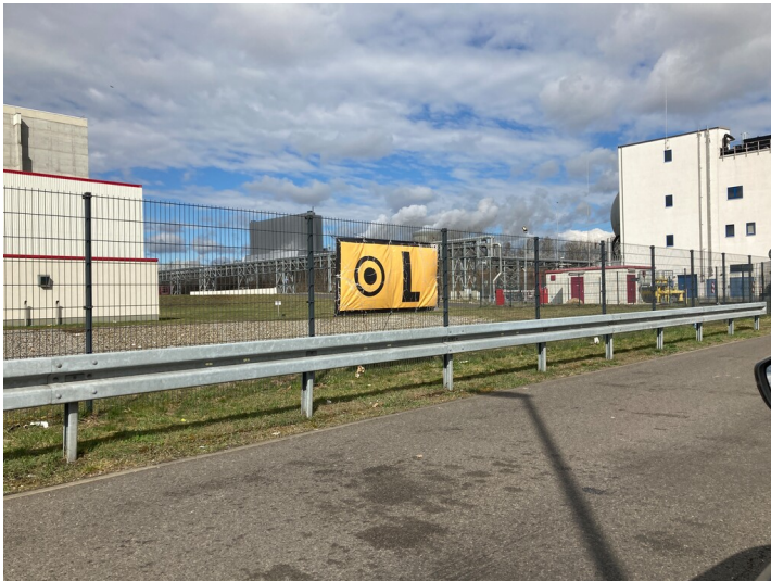
Abwasserbehandlungsanlage Industriepark Schwarze Pumpe Fotograf/Urheber: Martin Neubacher
