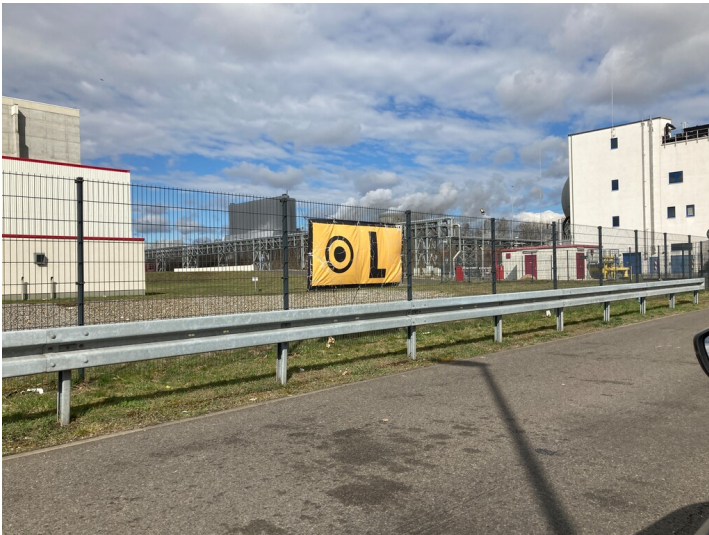
Abwasserbehandlungsanlage Industriepark Schwarze Pumpe Fotograf/Urheber: Martin Neubacher
