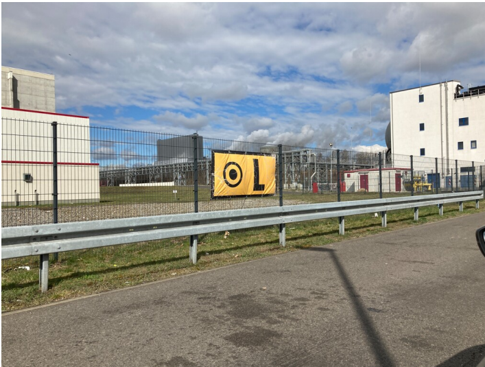
Abwasserbehandlungsanlage Industriepark Schwarze Pumpe Fotograf/Urheber: Martin Neubacher
