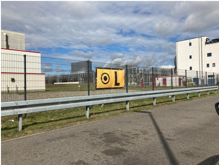
Abwasserbehandlungsanlage Industriepark Schwarze Pumpe Fotograf/Urheber: Martin Neubacher
