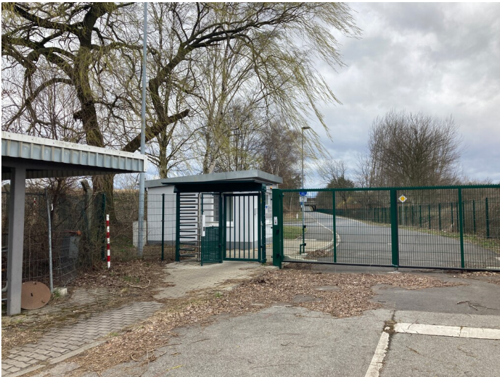
Kläranlage Ost Schwarze Pumpe Fotograf/Urheber: Matin Neubacher
