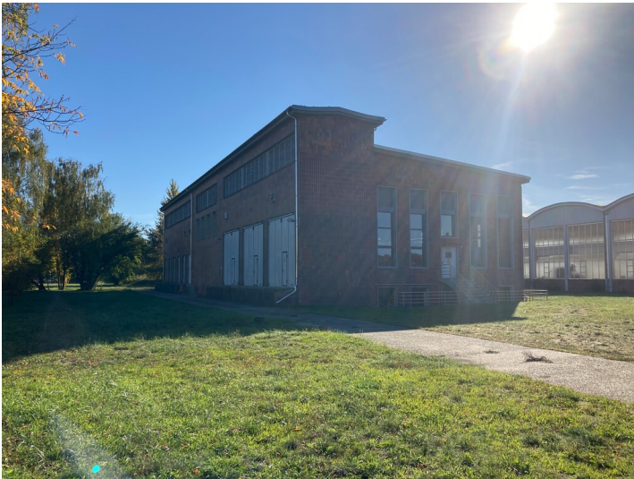
30-kV-Station Frischwasser Fotograf/Urheber: Martin Neubacher
