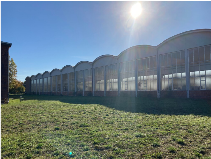
Zentrales Pumpenhaus Schwarze Pumpe Fotograf/Urheber: Martin Neubacher
