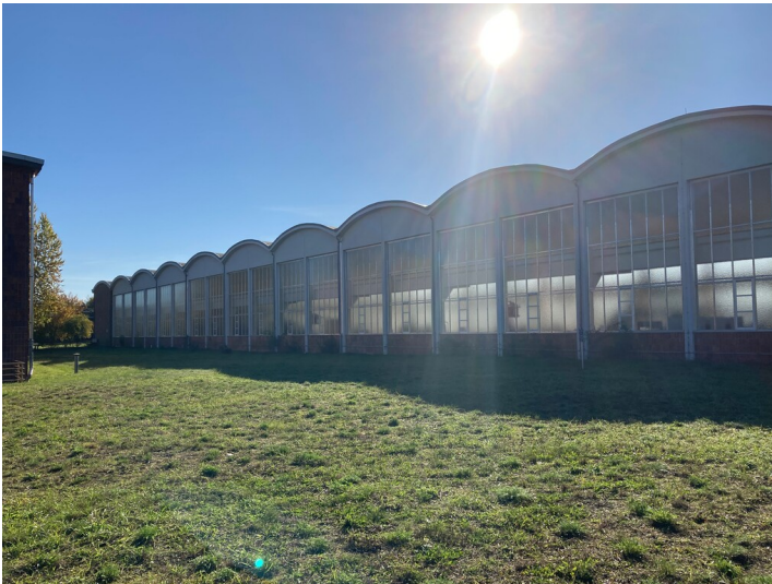
Zentrales Pumpenhaus Schwarze Pumpe Fotograf/Urheber: Martin Neubacher
