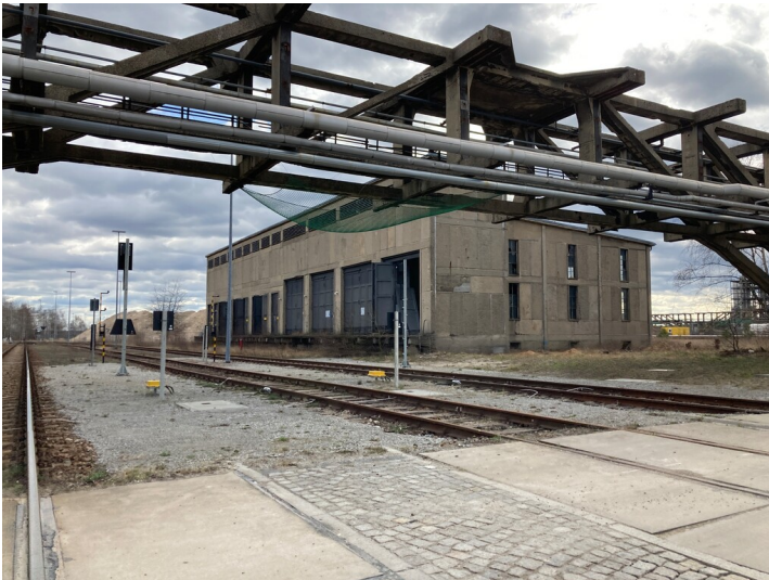
30-kV-Station Nebengewinnung Schwarze Pumpe Fotograf/Urheber: Martin Neubacher
