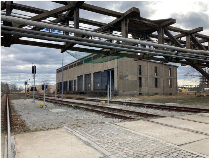
30-kV-Station Nebengewinnung Schwarze Pumpe Fotograf/Urheber: Martin Neubacher
