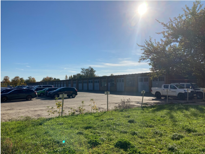
Fahrbereitschaft Schwarze Pumpe Fotograf/Urheber: Martin Neubacher
