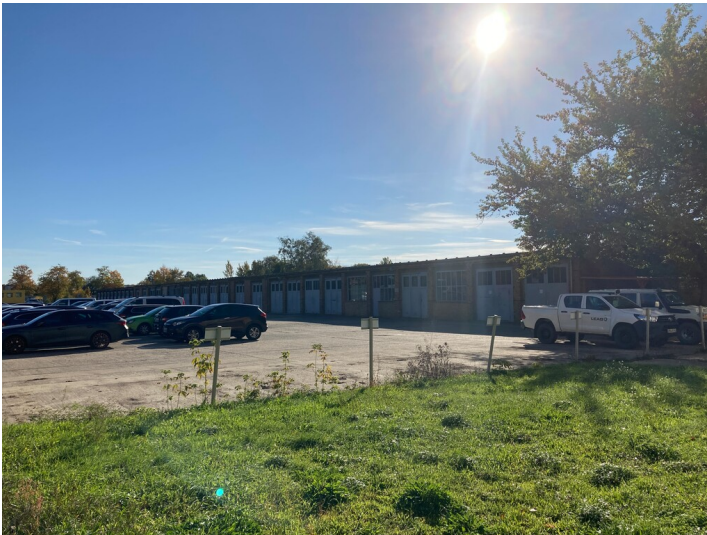
Fahrbereitschaft Schwarze Pumpe Fotograf/Urheber: Martin Neubacher
