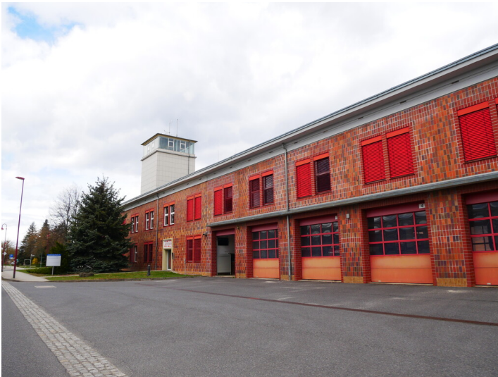
Hauptfeuerwache Haus 1 des Industrieparks Schwarze Pumpe Fotograf/Urheber: Kathrin Krüner
