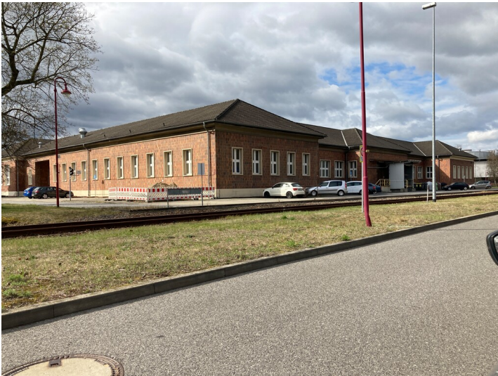
Zentralküche Schwarze Pumpe Fotograf/Urheber: Matin Neubacher
