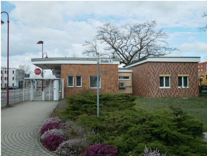
Pförtnerhäuschen Schwarze Pumpe mit Uhr Fotograf/Urheber: Kathrin Krüner
