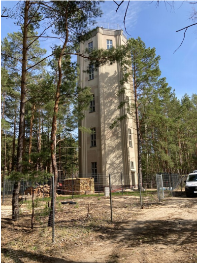
Wasserturm Spreewitz Fotograf/Urheber: Matin Neubacher
