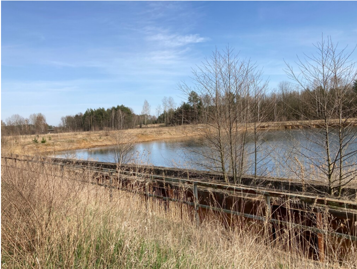
Grubenwasseraufbereitungsanlage Burgneudorf Fotograf/Urheber: Martin Neubacher
