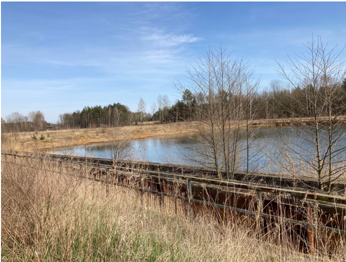
Grubenwasseraufbereitungsanlage Burgneudorf Fotograf/Urheber: Martin Neubacher
