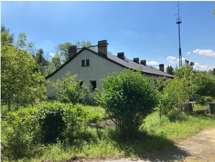
Mehrfamilienwohnhaus in Spreetal Fotograf/Urheber: Martin Neubacher
