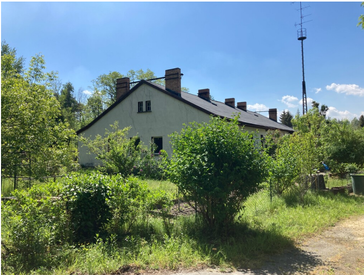
Mehrfamilienwohnhaus in Spreetal Fotograf/Urheber: Martin Neubacher
