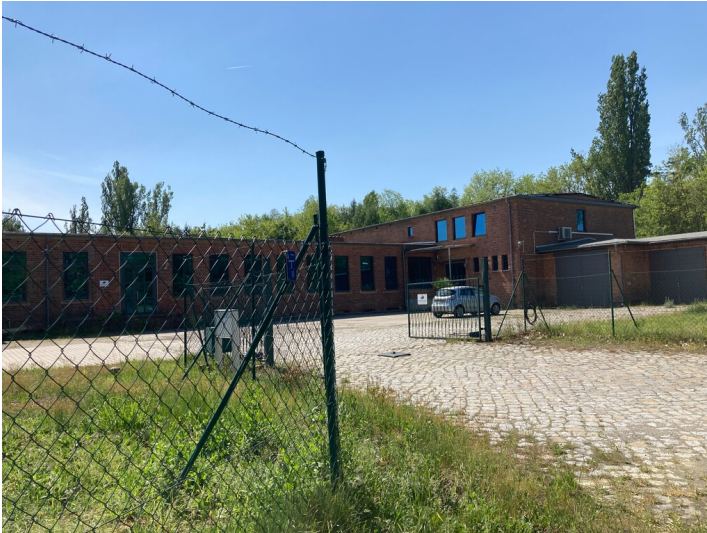
ehemalige Brikettfabrik Brigitta, Funktionsgebäude Fotograf/Urheber: Matin Neubacher
