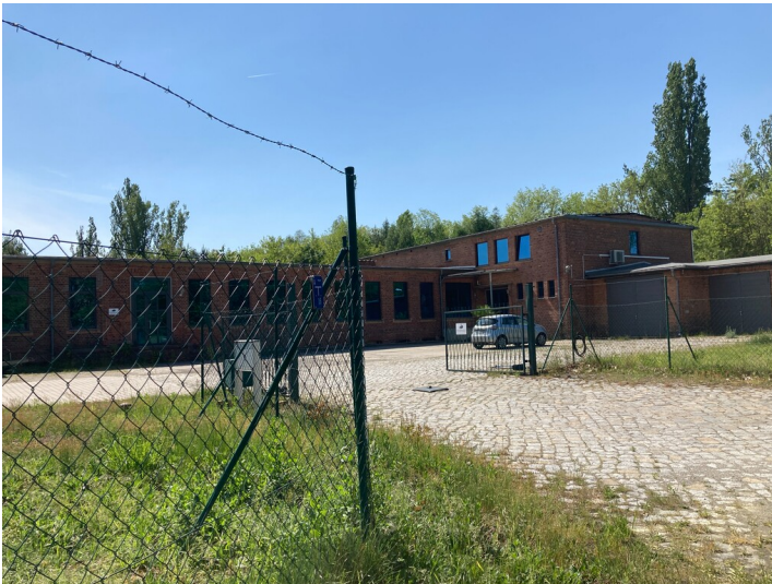
ehemalige Brikettfabrik Brigitta, Funktionsgebäude Fotograf/Urheber: Matin Neubacher
