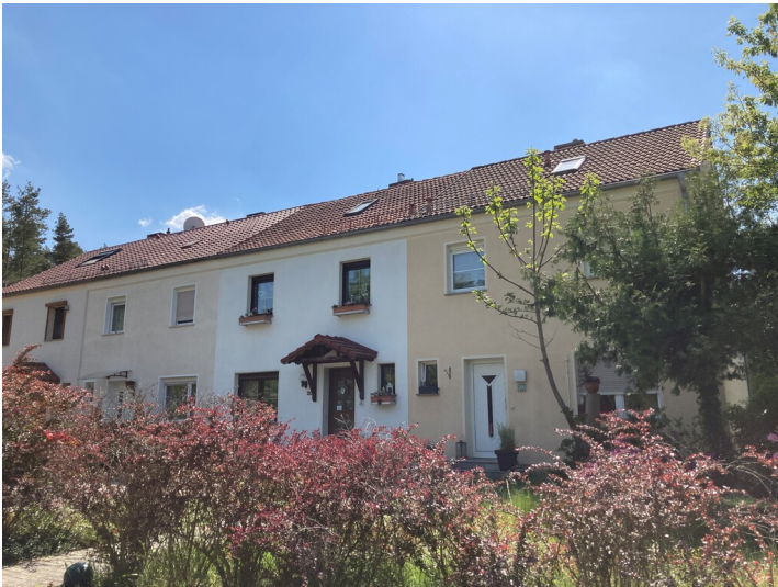
Mehrfamilienwohnhaus in Spreetal Fotograf/Urheber: Kathrin Krüner
