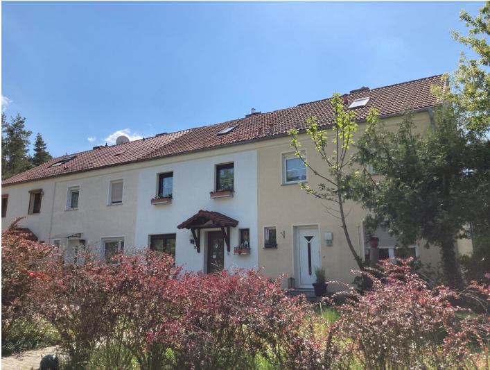
Mehrfamilienwohnhaus in Spreetal Fotograf/Urheber: Kathrin Krüner
