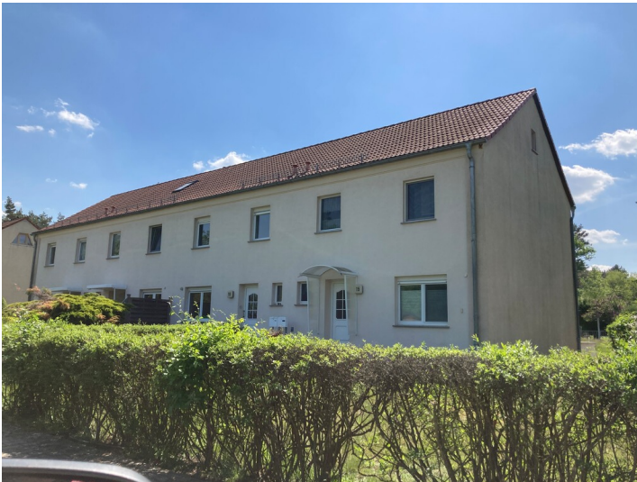
Mehrfamilienwohnhaus in Spreetal Fotograf/Urheber: Kathrin Krüner
