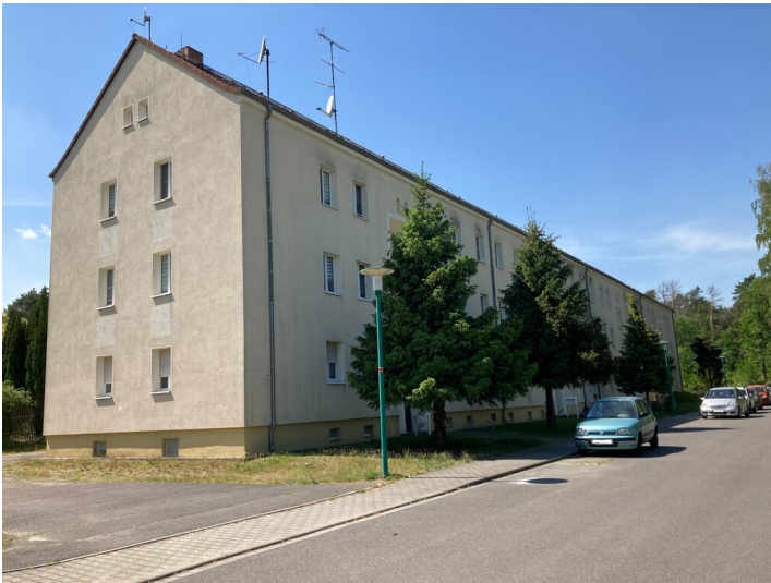
Mehrfamilienwohnhaus in Spreetal Fotograf/Urheber: Kathrin Krüner
