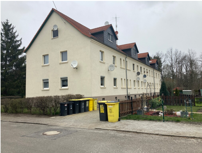
Mehrfamilienwohnhaus in Lauta Fotograf/Urheber: Martin Neubacher
