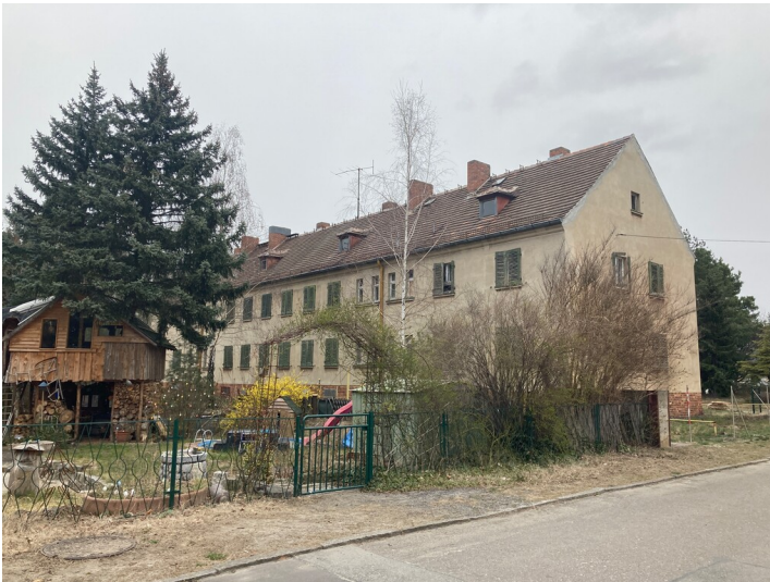
Mehrfamilienwohnhaus in Lauta Fotograf/Urheber: Martin Neubacher
