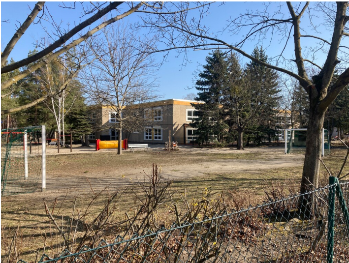
Kindergarten in Lauta-Süd Fotograf/Urheber: Martin Neubacher
