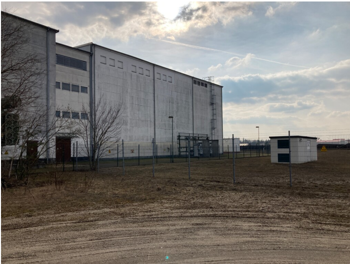
Umspannwerk des Lautawerks Fotograf/Urheber: Martin Neubacher
