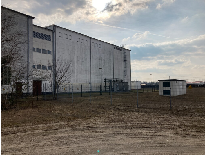
Umspannwerk des Lautawerks Fotograf/Urheber: Martin Neubacher
