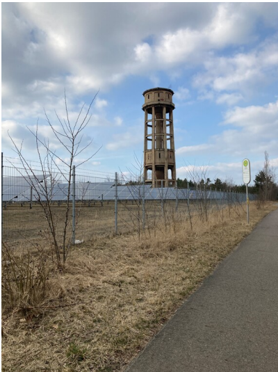
Wasserturm der ehem. Aluminiumhütte Lauta Fotograf/Urheber: Martin Neubacher
