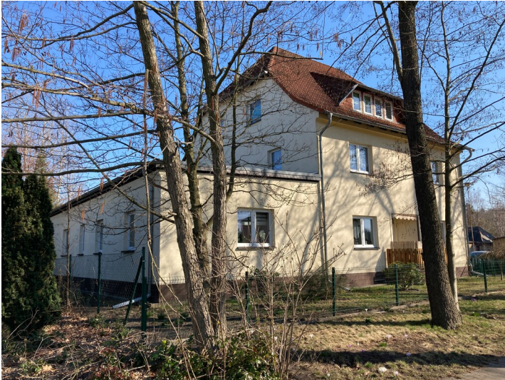
Mehrfamilienwohnhaus in der Kolonie Bergmannsheimstätten Fotograf/Urheber: Martin Neubacher
