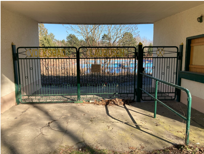
Volksbad Laubusch, Eingangsbereich Fotograf/Urheber: Martin Neubacher
