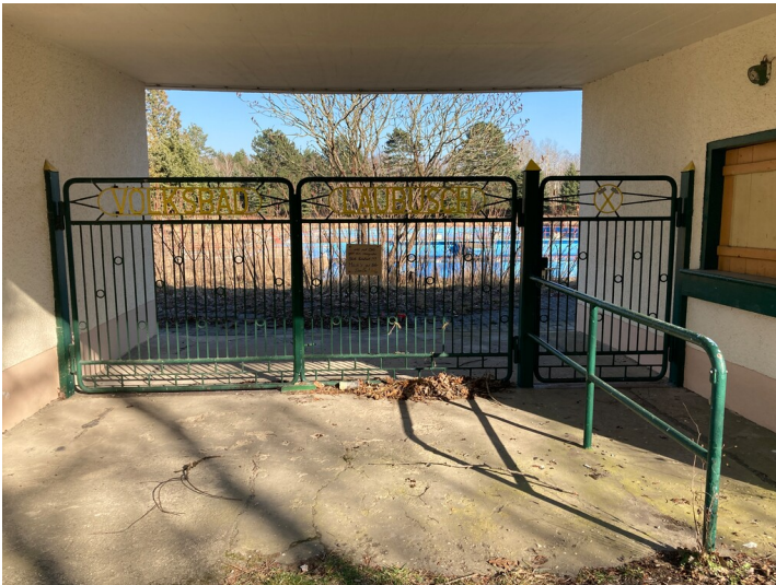
Volksbad Laubusch, Eingangsbereich Fotograf/Urheber: Martin Neubacher
