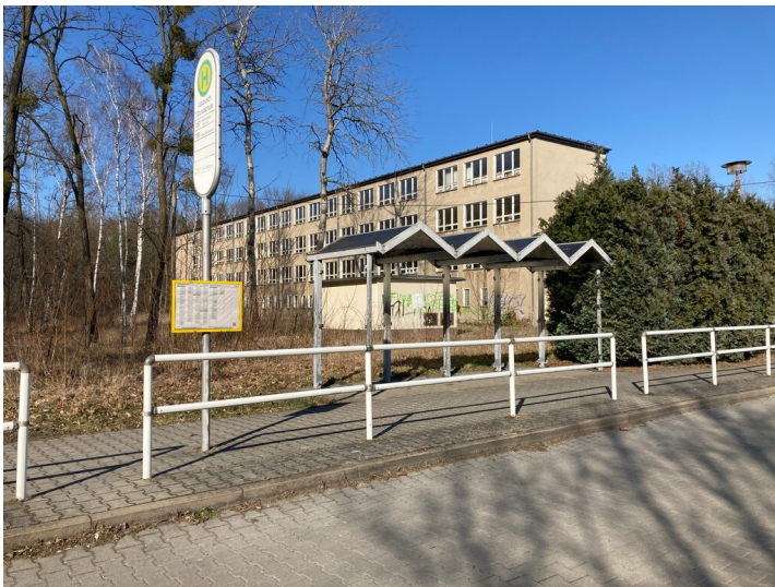
ehem. Polytechnische Oberschule "Kurt Krjenc" in Laubusch; heute Kindergarten Fotograf/Urheber: Martin Neubacher
