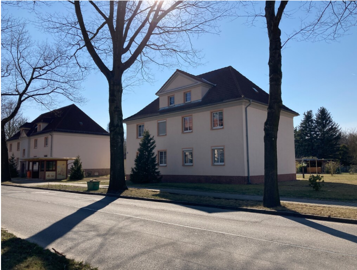
Mehrfamilienwohnhäuser mit Nebengebäuden in der "Kolonie Bergmannsheimstätten" Fotograf/Urheber: Martin Neubacher
