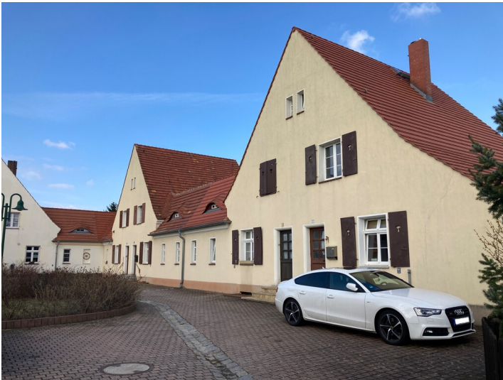
ehem. Arbeiterwohnhaus in der Gartenstadt Lauta-Nord Fotograf/Urheber: Martin Neubacher
