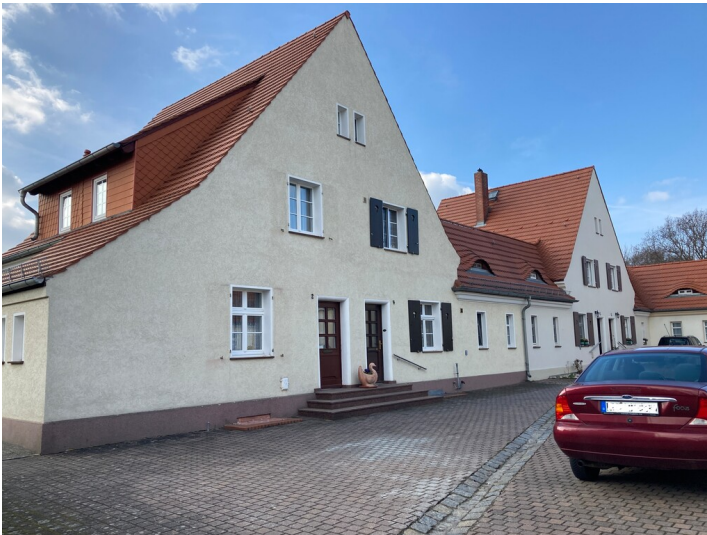
ehem. Arbeiterwohnhaus in der Gartenstadt Lauta-Nord Fotograf/Urheber: Matin Neubacher
