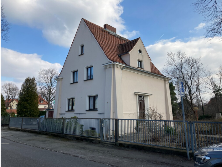
ehem. Kath. Pfarrhaus der Gartenstadt Lauta-Nord Fotograf/Urheber: Matin Neubacher
