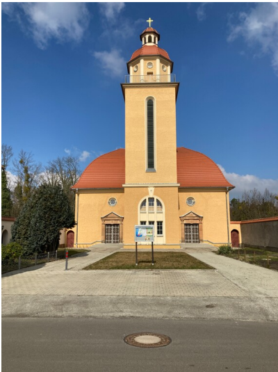
Südfassade der Ev. Stadtkirche der Gartenstadt Lauta-Nord Fotograf/Urheber: Matin Neubacher
