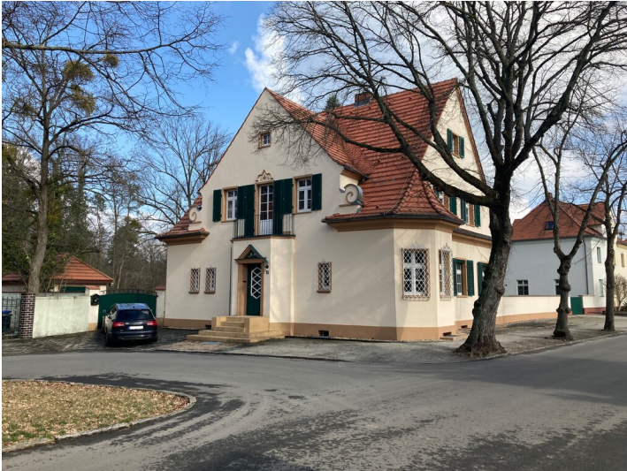
ehem. Pfarrhaus in der Gartenstadt Lauta-Nord Fotograf/Urheber: Martin Neubacher
