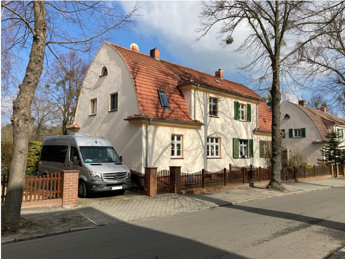
ehem. Beamtendoppelwohnhaus in der Gartenstadt Lauta-Nord Fotograf/Urheber: Matin Neubacher
