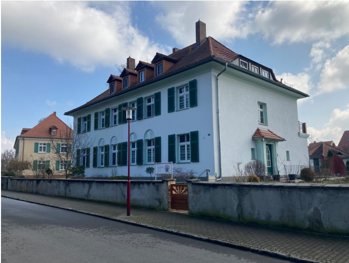
ehem. Beamtenwohnhaus in der Gartenstadt Lauta-Nord Fotograf/Urheber: Matin Neubacher
