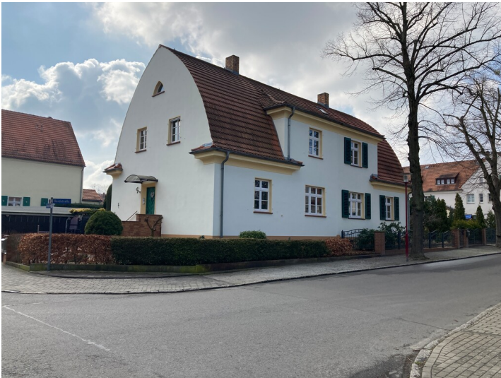
ehem. Beamtendoppelwohnhaus in der Gartenstadt Lauta-Nord Fotograf/Urheber: Martin Neubacher
